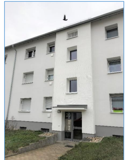
Energetische Sanierung Bundeswehrwohnanlage
