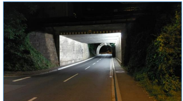
Unterführung Würzburger Straße mit LED-Technik
