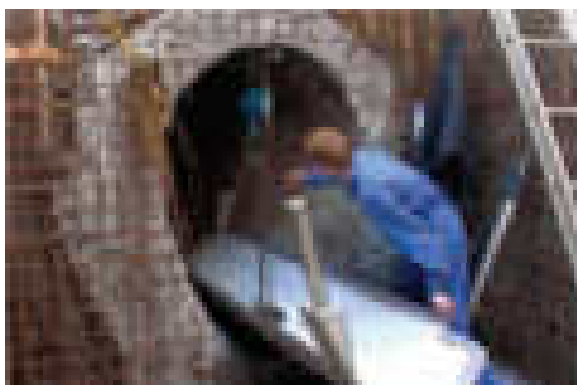
Abbildung 10.1.3: Einbringen des Wärmetauschers in einen bestehenden Kanal und vorgefertigtes Kanalelement (Quellen: EBM, Rabtherm)
