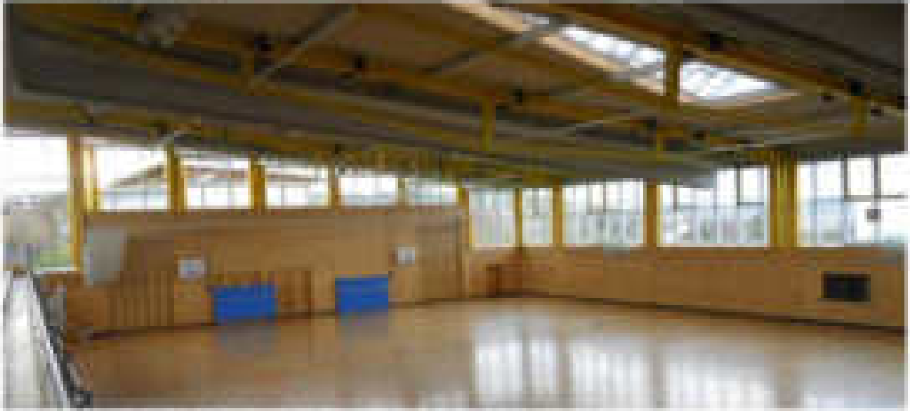
Blick in den Saalbereich mit Lüftung und Deckenplanung. Betonierung Saalfläche
