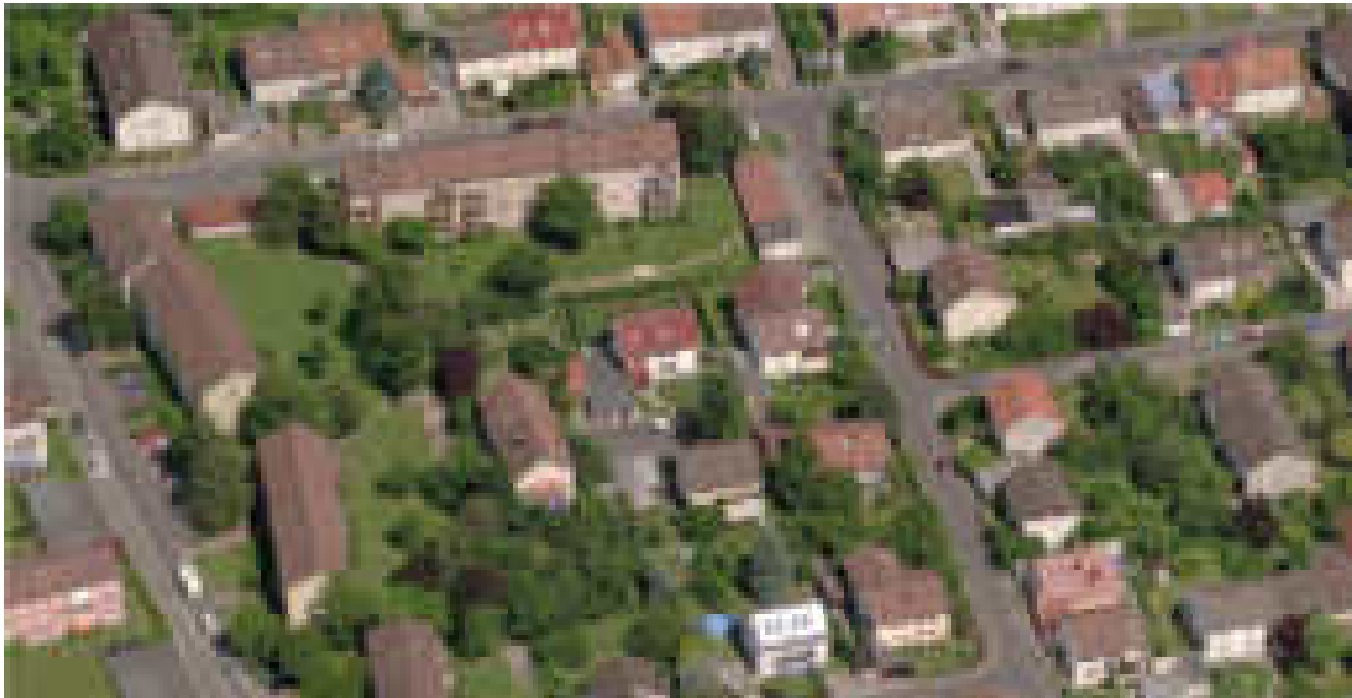
Abbildung 4.1.7: Luftbild Gartensiedlung (Quelle: bing maps)
