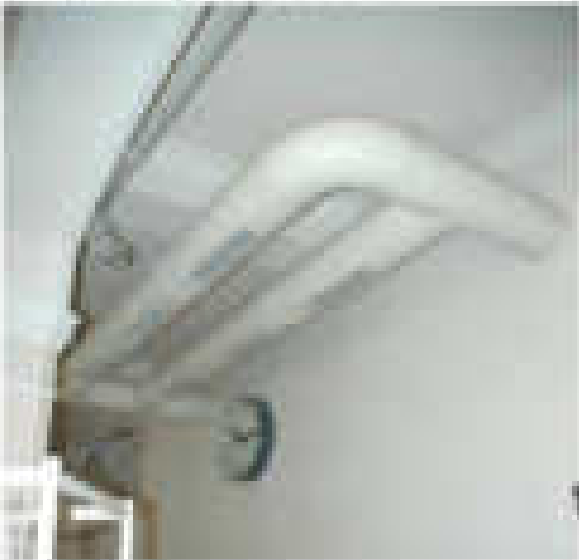
Baum 11 Lüftung an Holzoberfläche
