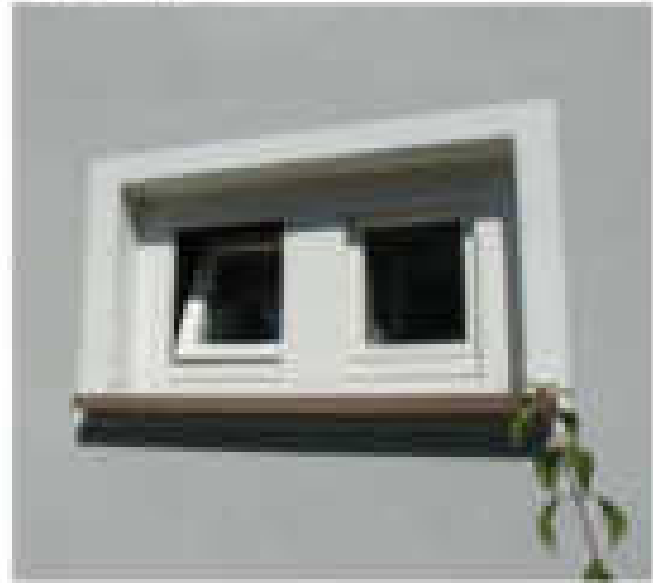
Baum 12 Doppel Fenster
