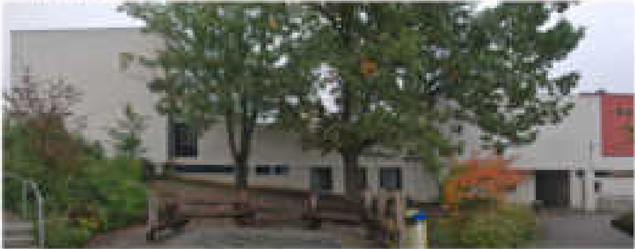
Baum 2: Ansicht Nord Ost
