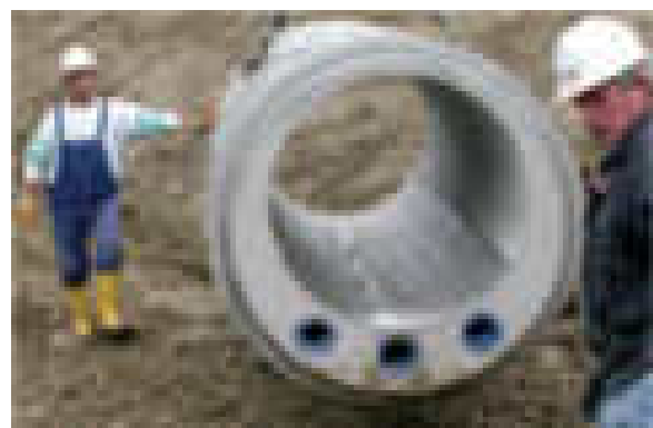
Abbildung 10.1.3: Einbringen des Wärmetauschers in einen bestehenden Kanal und vorgefertigtes Kanalelement (Quellen: EBM, Rabtherm)
